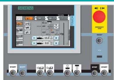
CONTROL PANEL:SIEMENS (X)
